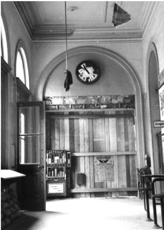
Zerstörter Bahnhofsüdflügel nach Einschlag einer Sprengbombe. Betroffen waren Fahrdienstbüro und Billettschalter. (Foto Stadtpolizei Schaffhausen, Sammlung Stadtarchiv)
